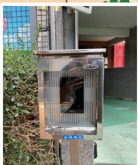
1131007 停車場出入口增置車道對講機
