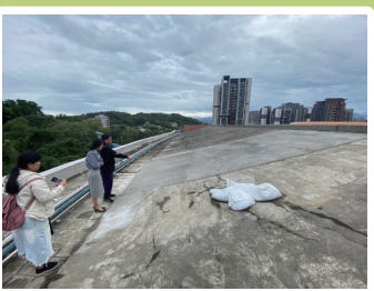
1131119教學大樓A.C棟頂樓地震災損修復工程
